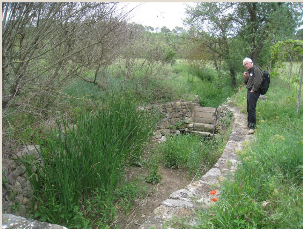
Réalisation d'un seuil
