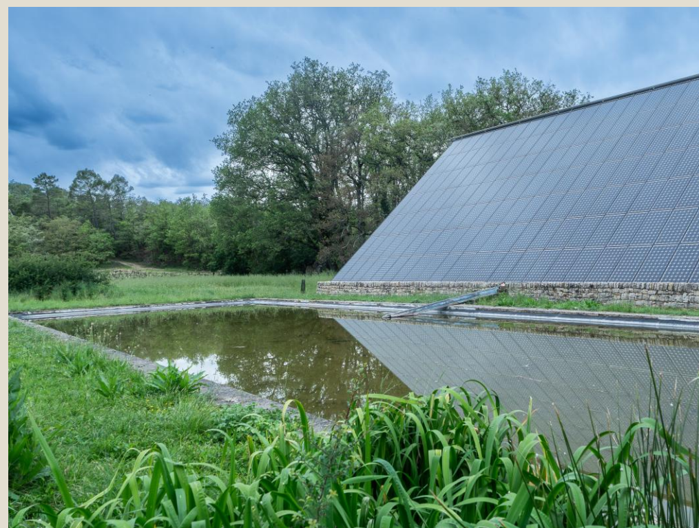
Bassin qui recueille l'eau de pluie
