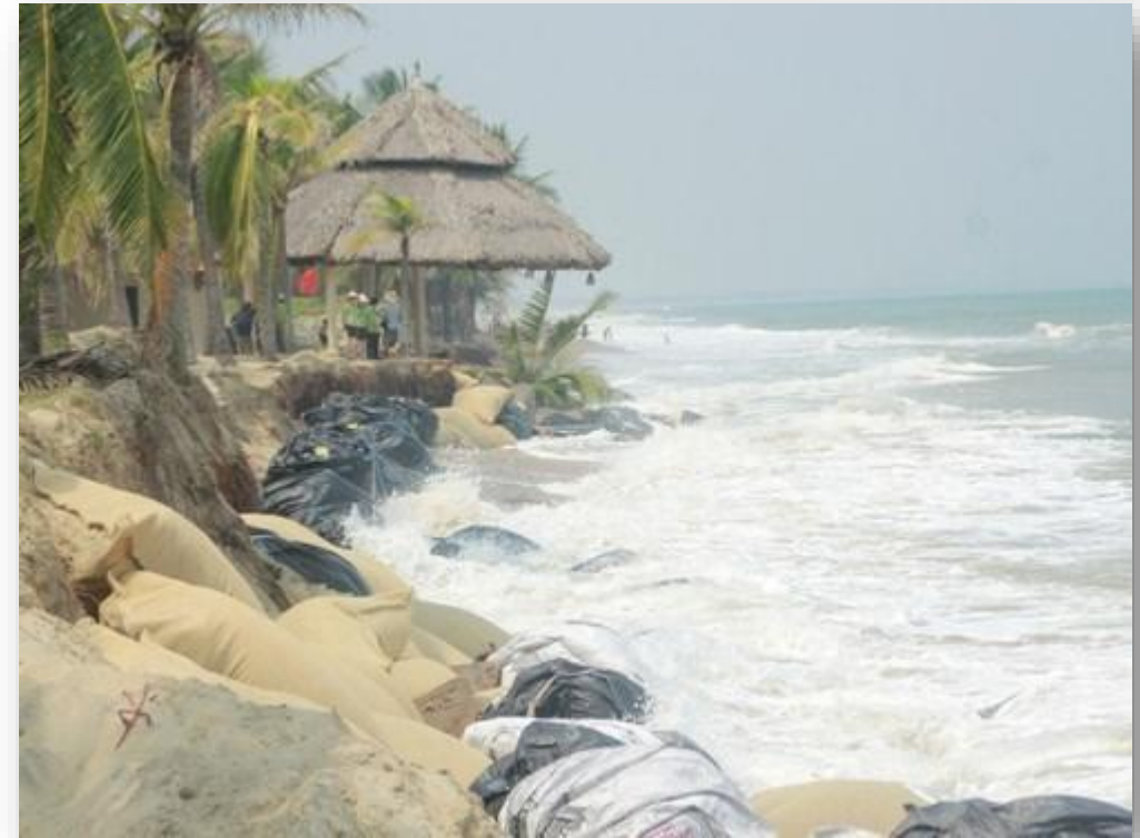
10 mm d'élévation de la mer = 1 m d'érosion côtière Plage de Hoi An, Viêt-Nam. Photo: Hoang Son
