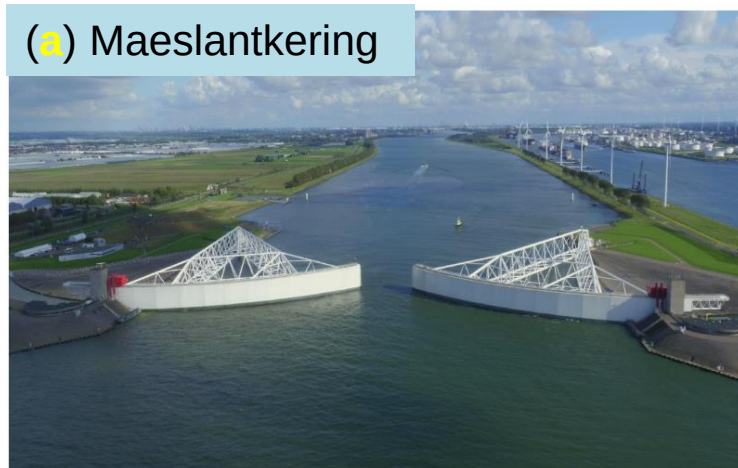
Barrière mobile qui ferme le port de Rotterdam
