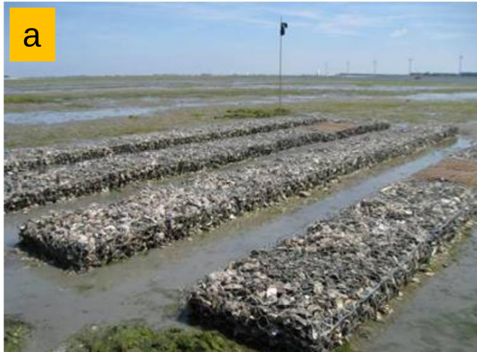
Gabions de coquillages d'huîtres (Deltares)
