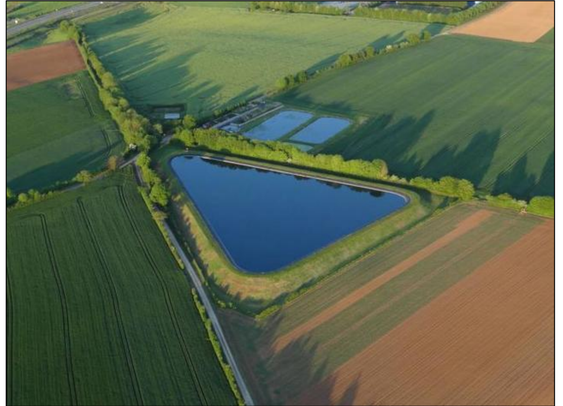
Bassin de rétention sur le bassin versant de la Charente
